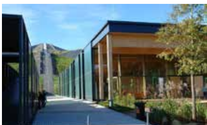
Bergisches Energiekompetenzzentrum Lindlar
